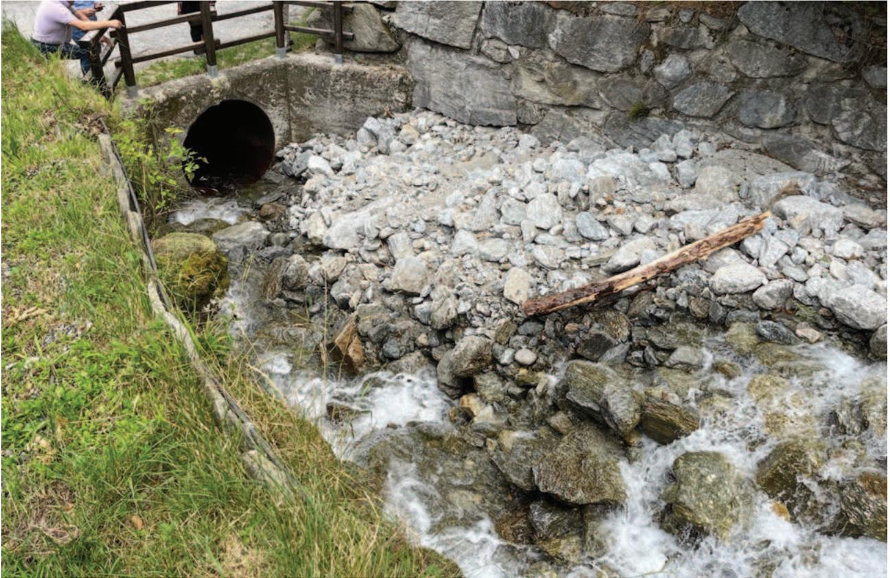
Località Nora – Pulizia mediante rimozione del materiale depositato in alveo
