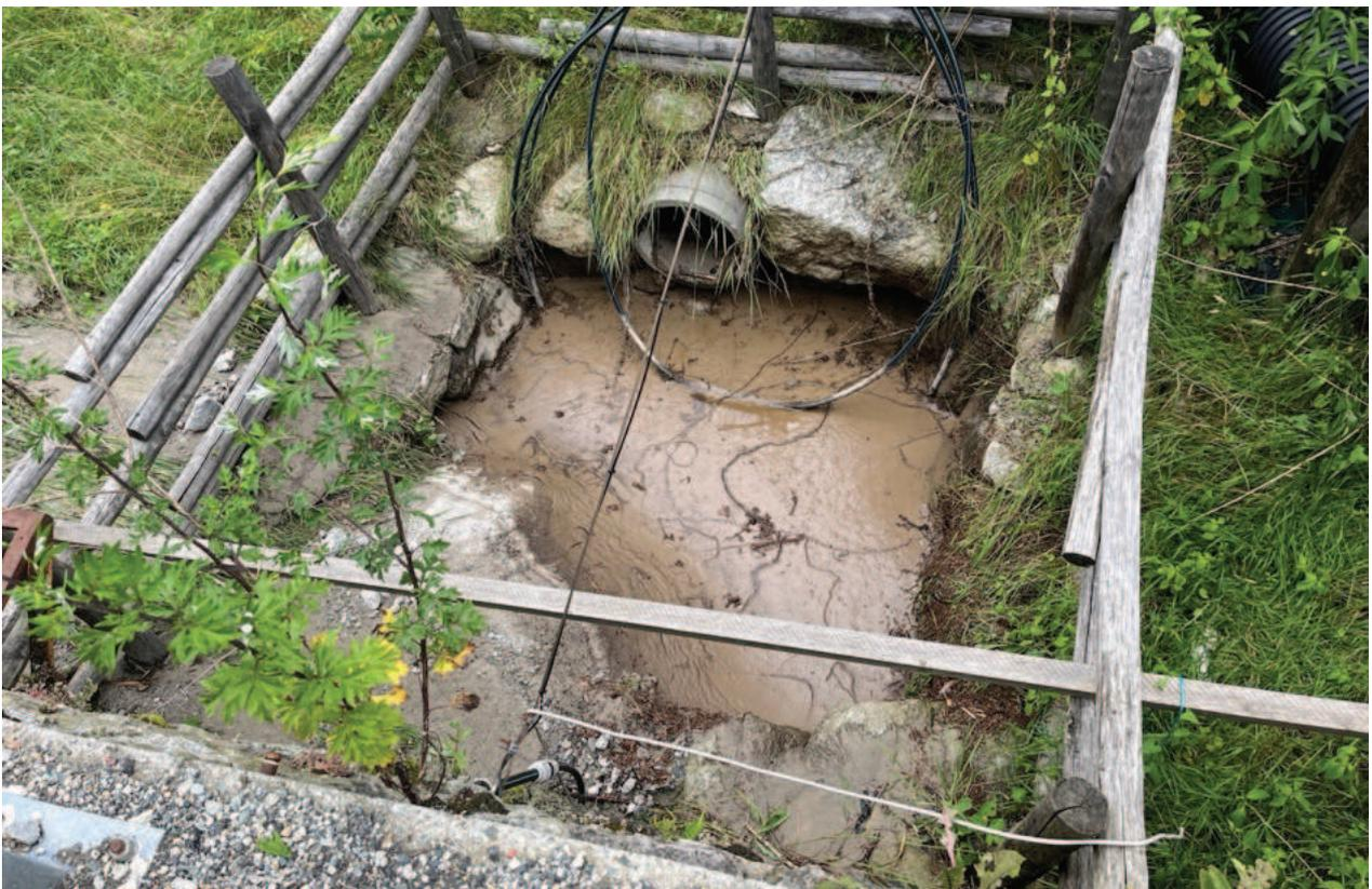
Vasca di decantazione a monte dell'attraversamento stradale in prossimità dell'abitato colmata a seguito dell'evento esondivo
