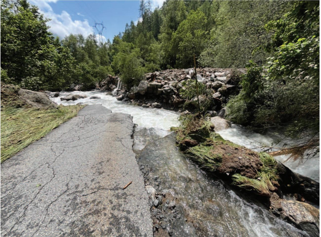
Località San Giacomo – Erosione della viabilità da parte delle acque di esondazione del torrente Piantonetto
