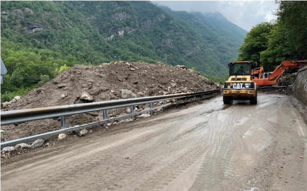
Lavori di somma urgenza per ripristinare il transito sulla ex S.S. n° 460 (domenica 30 giugno 2024). Il materiale detritico rimosso è stato provvisoriamente accumulato a lato della viabilità
