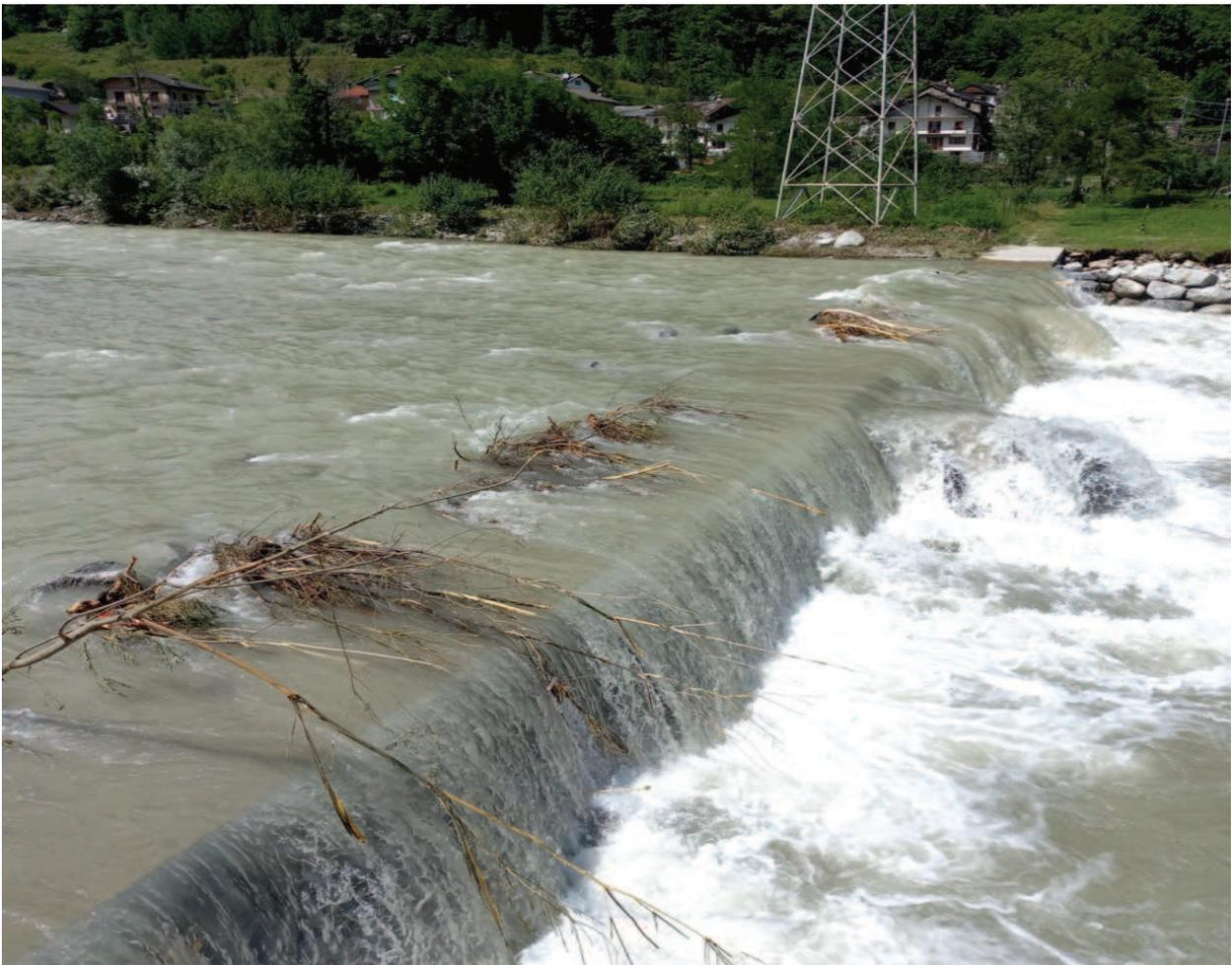
Guado località Casetti – L'accumulo di materiale detritico a monte del guado e la conseguente ostruzione delle tubazioni al di sotto del piano carraio è causa del transito delle acque al di sopra dello stesso
