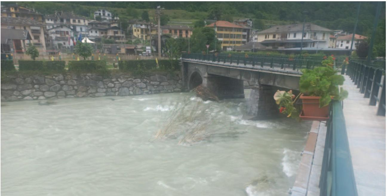
Ponte Villa (Capoluogo) – Necessaria pulizia dell'alveo in prossimità del ponte Villa con eventuale verifica della stabilità statica delle pile del ponte stesso
