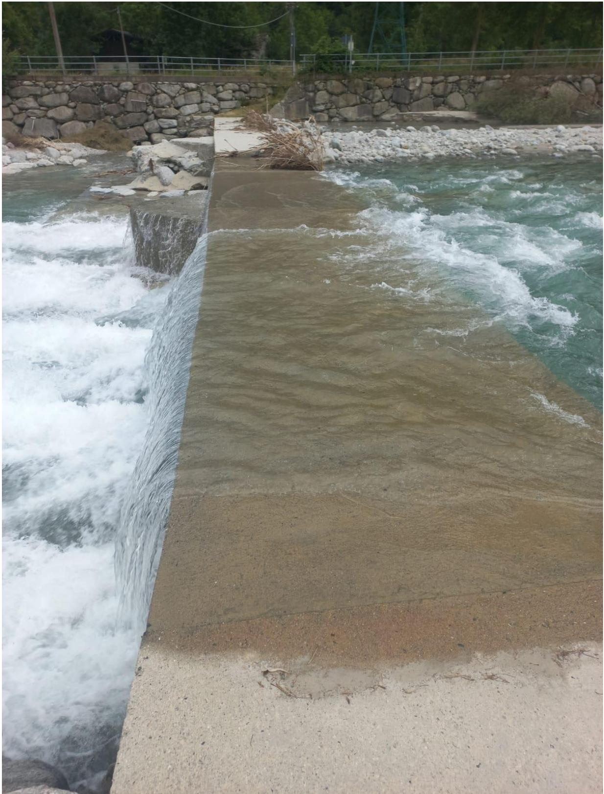
Foto 1 – Sovralluvionamento a monte dell'infrastruttura e evidente deposito a monte della stessa
