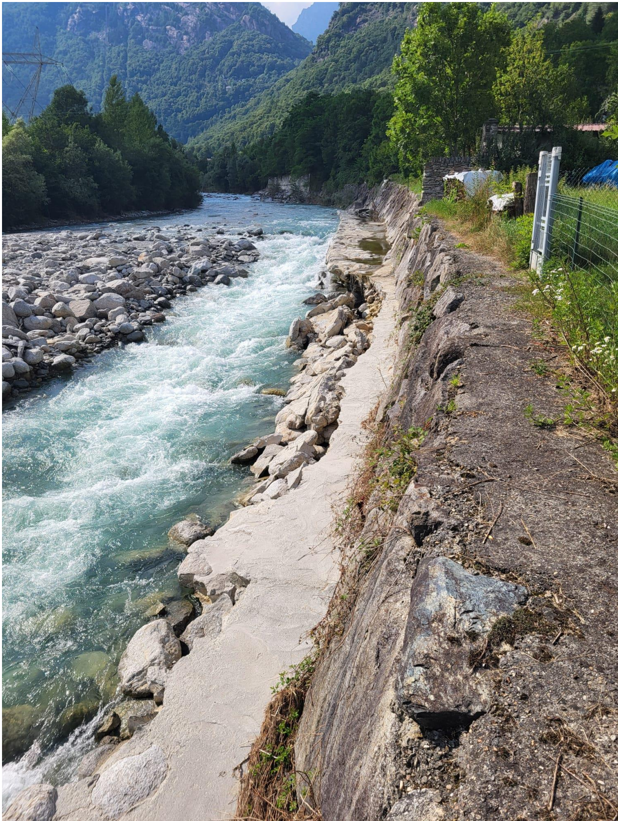
Foto 2 – Vista generale della sottomurazione
